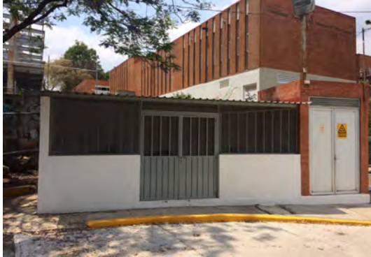
Figura 43: Imagen del almacén de residuos peligrosos del CCG
