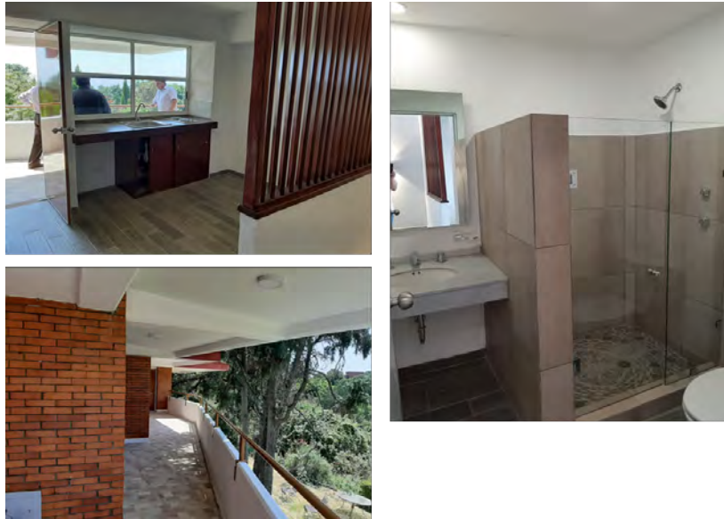
Figura 35: Imágenes de la rehabilitación de la Unidad Habitacional del CCG
