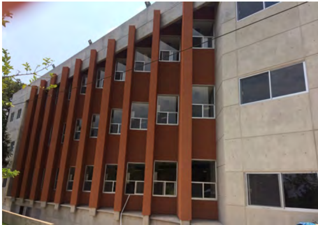
Figura 33: Vista del edificio de laboratorios que alberga el programa de Biología de Sistemas y Biología Sintética
